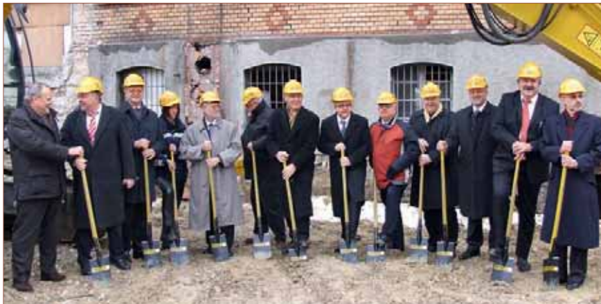
Baubeginn auf dem Gelände des Hochschulcampus im Dezember 2008.
